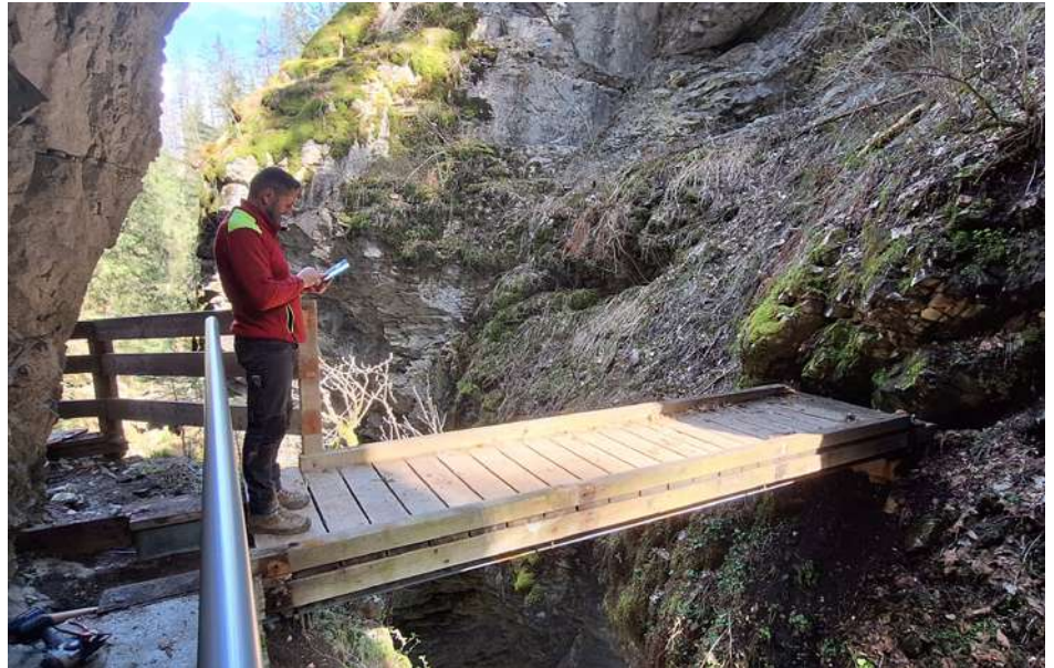
41 Brücken und zwölf Übergänge haben Franz und seine Helfer im Laufe der Jahre errichtet und immer wieder saniert oder erneuert
